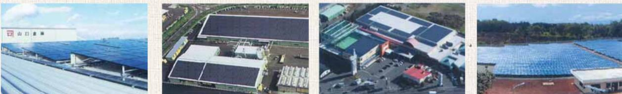
福島県郡山市/山口倉庫(株)様 シャープ製 200kW 薄膜結晶タイプ太陽電池を倉庫の折板屋根に設置。遮熱効果による空調負荷や、CO2を削減。
